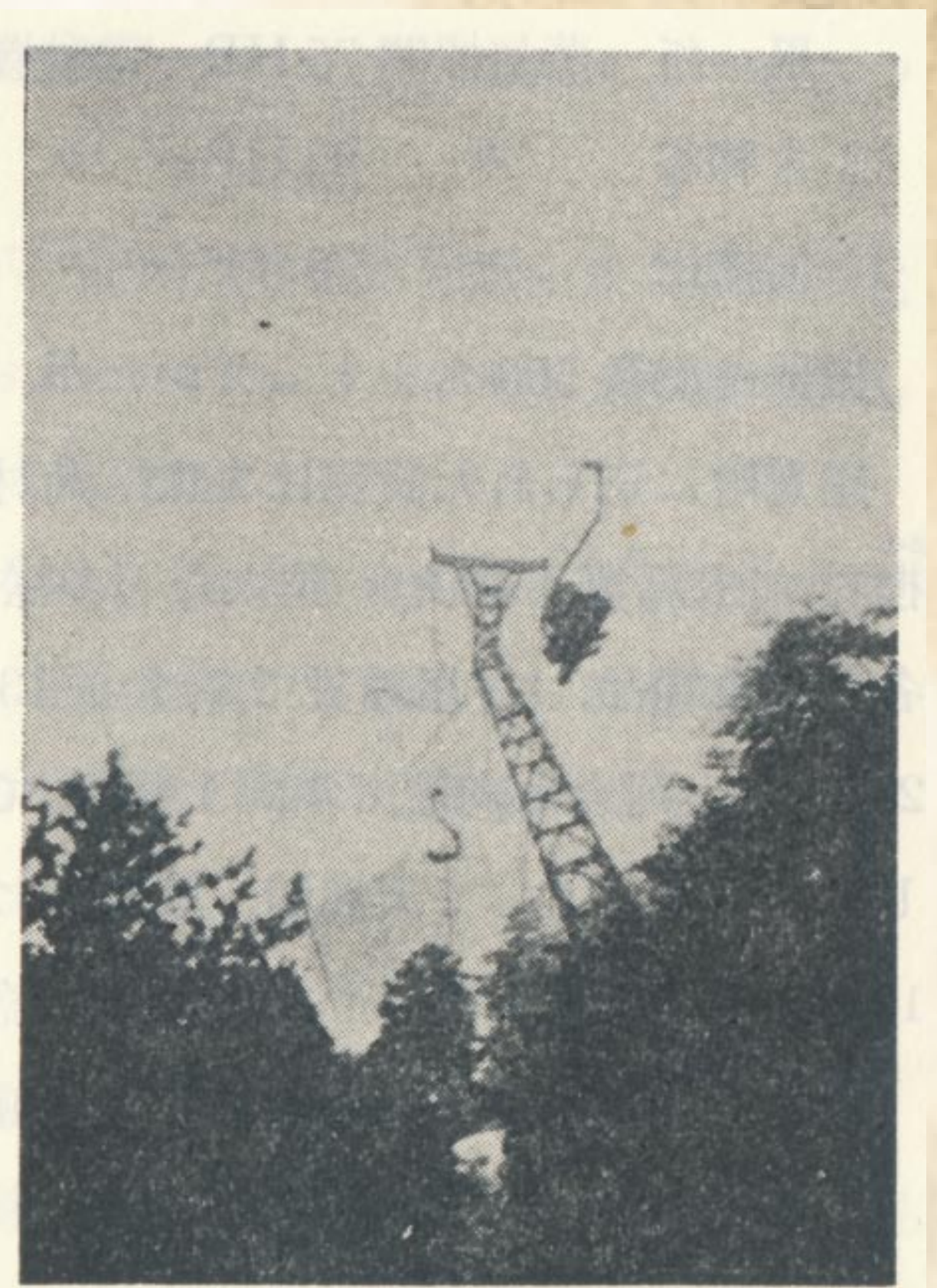
図 4-7 北山索道傾斜支柱
